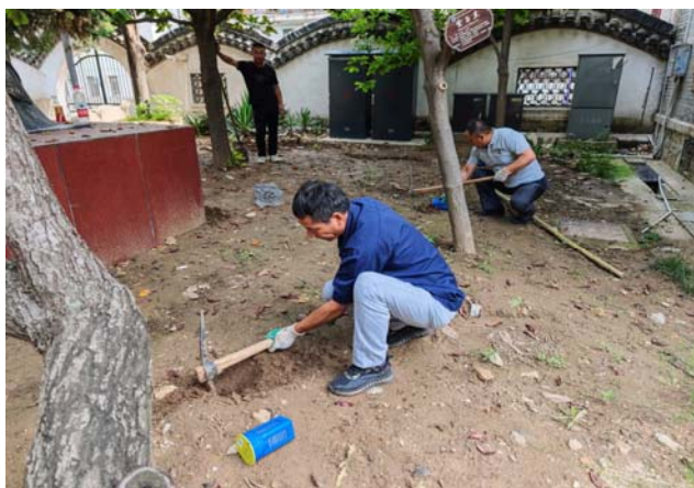
图4 蚌埠市白蚁所众人安装地下型杀白蚁饵剂监测系统
